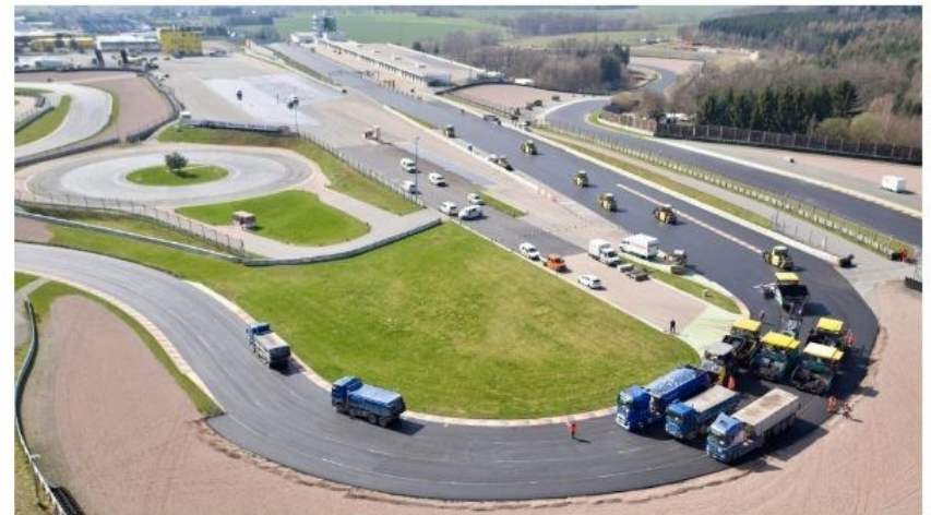
Mit Asphaltmaschinen und Walzen wird eine neue Asphaltdecke aufgebracht. Foto: Jan Woitas/Archiv Foto: Jan Woitas
